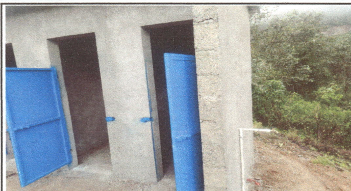
Foto 1: Mejoramiento de paredes a blocks de los baños, columna, cambio de letrina a inodoro, cambio de techo a lamina troquelada, costanera, tubería de drenaje a fosa séptica. Sustitucion de3 puertas a metal.
