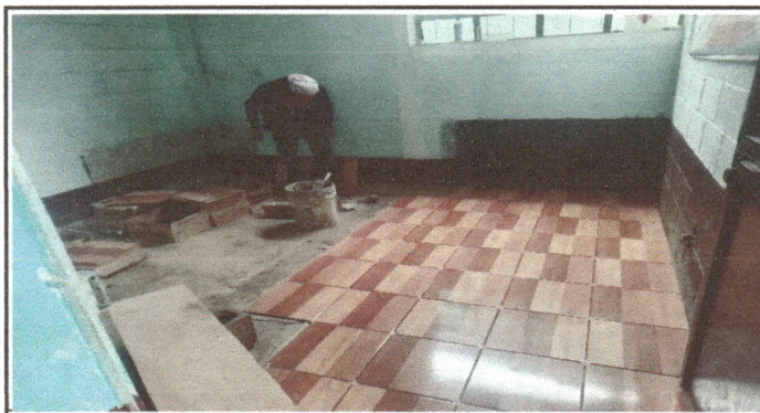
Foto 5: Mejoramiento de piso de concreto a piso cerámico de 33*33 en área de bodega y direccion.
