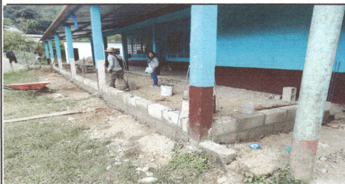
Foto 3: Reparacion de piso de tierra a piso de concreto alisado natural en área de corredor. Con baranda de 4 hiladas de block en el perimetro del corredor.
