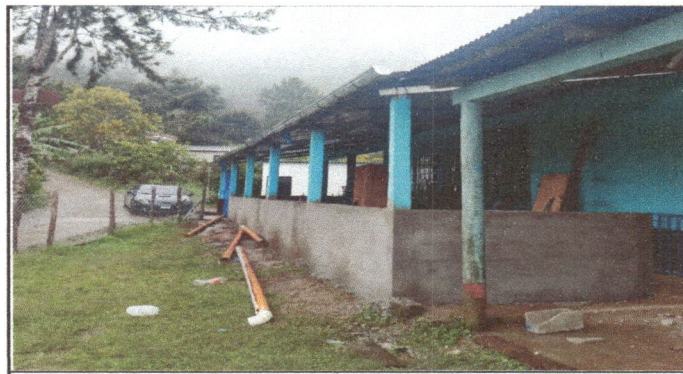
Foto 6: Sustitucion de canal a canal de metal con baja de agua pluvial. Colocacion de porton en entrada principal.
